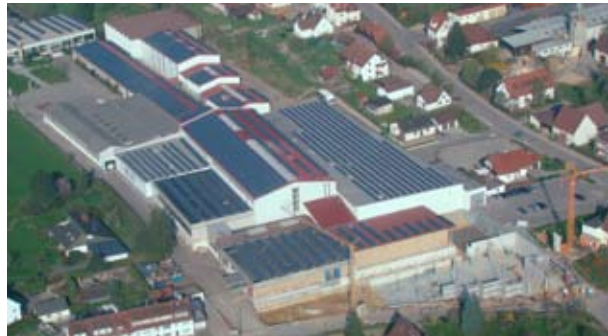
800 kWp installierte Leistung auf Hallendächern
