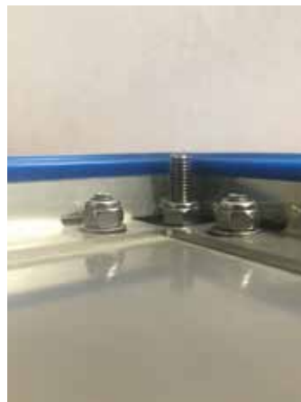
Vue intérieure du couvercle / dispositif anti-perte
