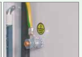
Schutzleiteranschluss Bolzen an Korpus und Tür
